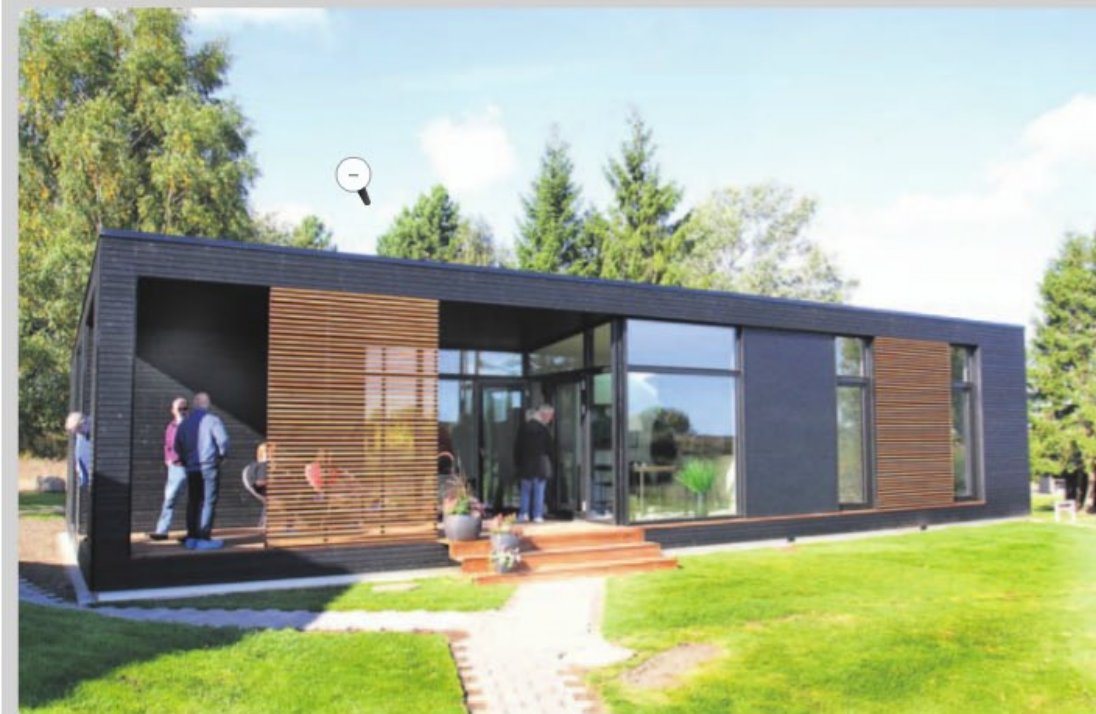
EBK HUSEs nye fritidshus er langt fra den klassiske sommerhusstil med småsprossede vinduer, og det er helt bevidst. Foto: Georg Hemmingsen
